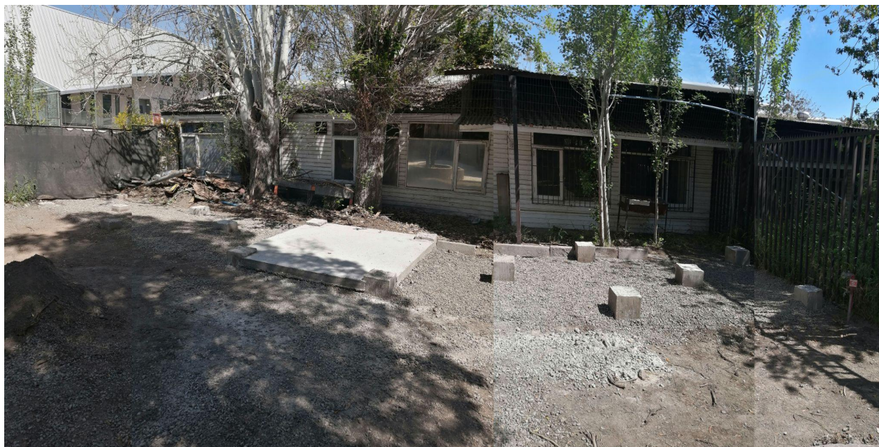
Registro de fundaciones para Contenedores terminadas
