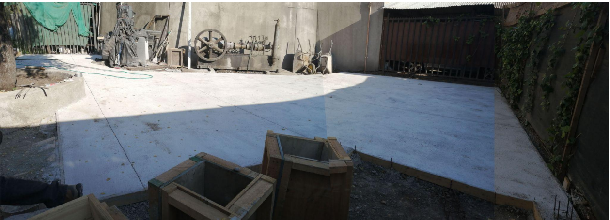
Registro de Radier terminado para Galpón
