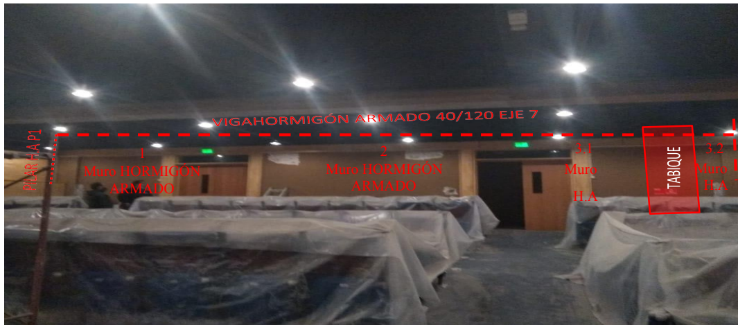
Ubicación de tabique en muros de acceso auditorio María Ghilardi. Eje 7.
