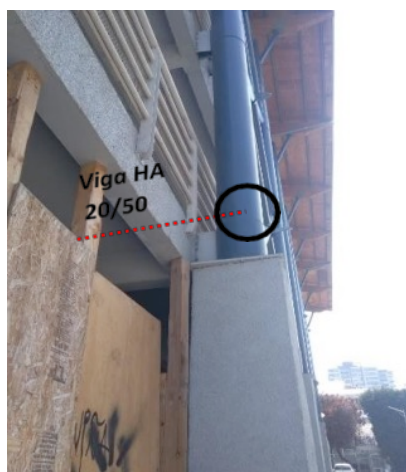
Fotografía viga pasillo oriente Eje 1. Empotramiento a pilar de acero tubular.
