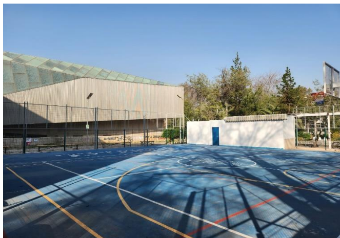
Registro fotográfico Proyecto Terminado
