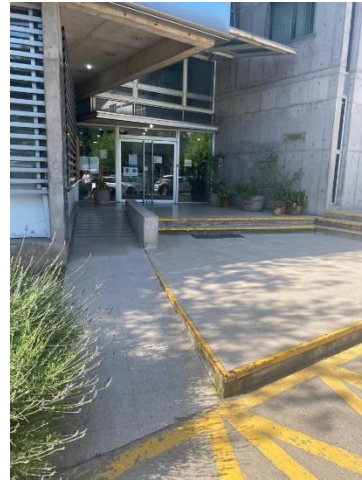
Rampa de acceso edificio de Biología Milenio
